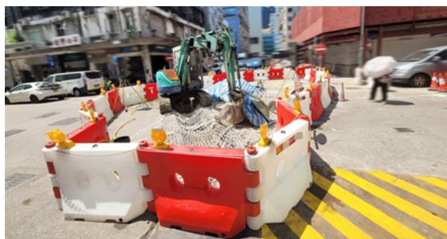
使用防護圍欄，劃出一個安全的工作地帶 Protection barriers used to ensure a safety working zone
